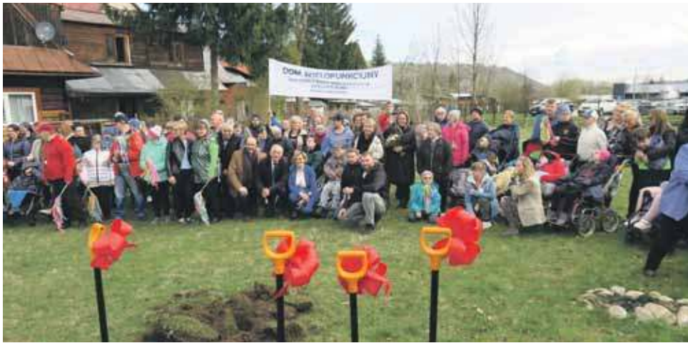
Po wbiciu pierwszych łopat, wspólne zdjęcie na placu budowy.
