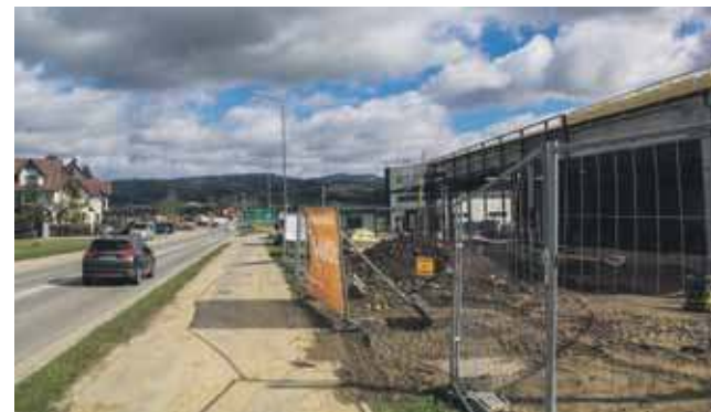
Budowa nowego Lidla.
