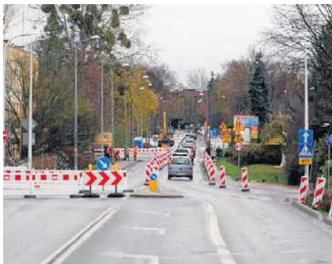
Od połowy listopada ulica Swojczycka jest jednokierunkowa. Ruszyła budowa trasy tramwajowej
