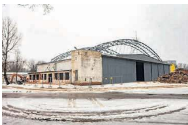
Prace rozbiórkowe w Hangarze Czyżyny związane z modernizacją obiektu
