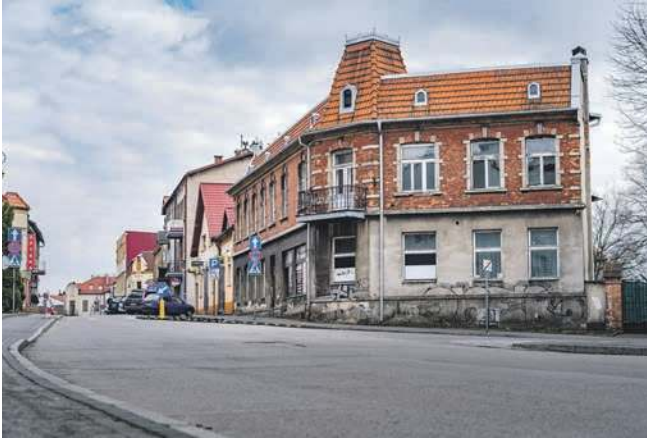
Aktualny wygląd budynku
