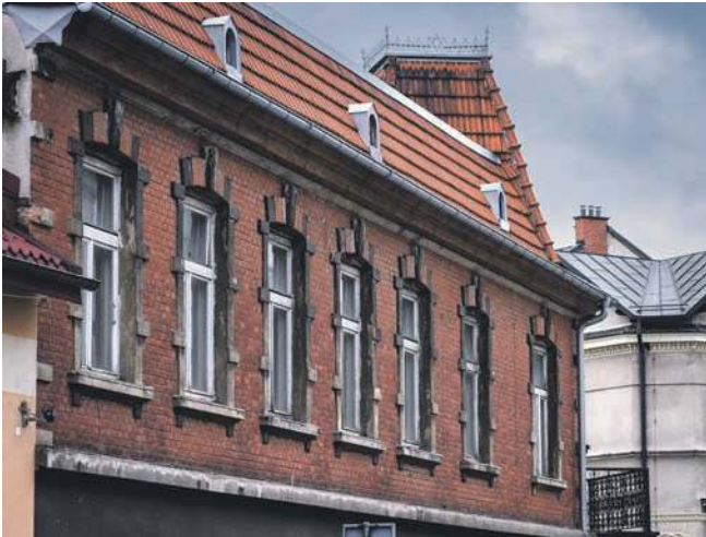
Ceglana fasada piętra z ozdobnymi elementami wokół okien
