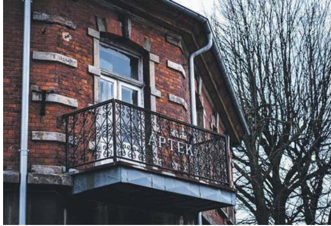
Umieszczony na piętrze w narożnej części budynku balkon
