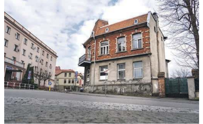
Dokonana przebudowa budynku zdecydowanie nie poprawiła jego pierwotnej estetyki
