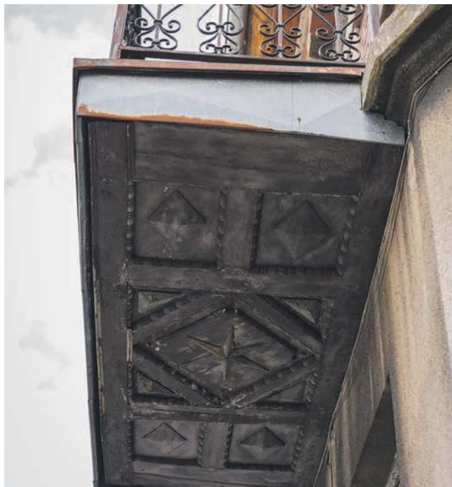
Wykonane z drewna podbicie balkonu z charakterystyczną gwiazdą
