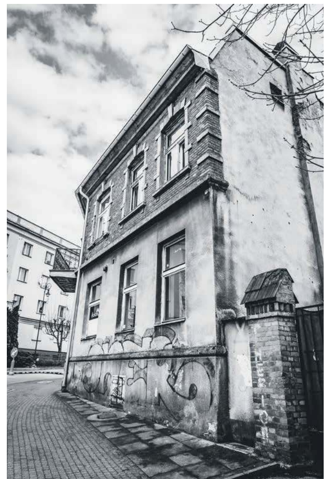
Fragment elewacji od ul. Kościuszki
