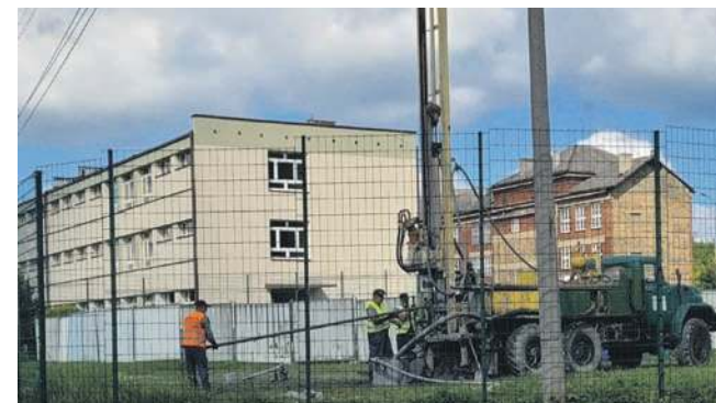
Prace przy SP nr 5 w Sierszy
