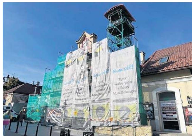
Ostatnim elementem robót jest remont elewacji od strony ulicy Solnej
