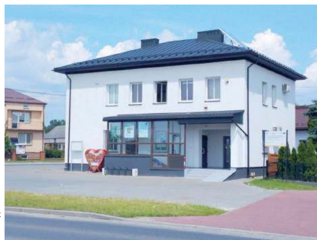
W Majdanie Nowym odnowiono budynek gminny przy rondzie, w którym mieści się siedziba Koła Gospodyń Wiejskich
