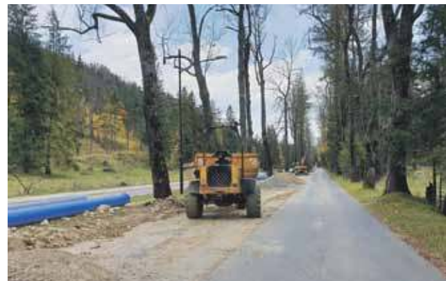
Na alei prowadzącej do Kuźnic pracuje ciężki sprzęt.
