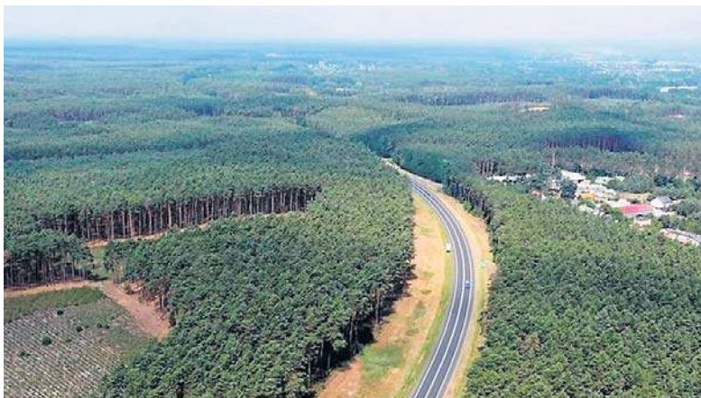
Kilka dni temu wybrano wykonawców na dwóch ostatnich odcinkach w bydgoskiej części woj. kujawsko-pomorskiego
