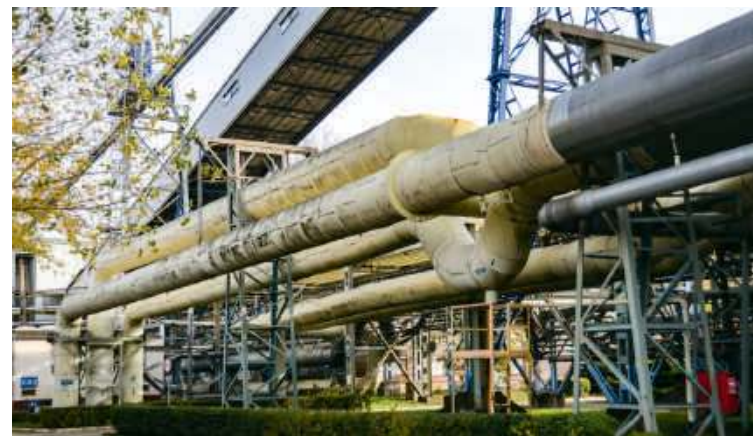
Inwestycja ta polega na wykonaniu nowego, długiego na ok. 450 m odcinka magistrali ciepłowniczej | fot. Janusz Wolniak/Gazeta Polska
