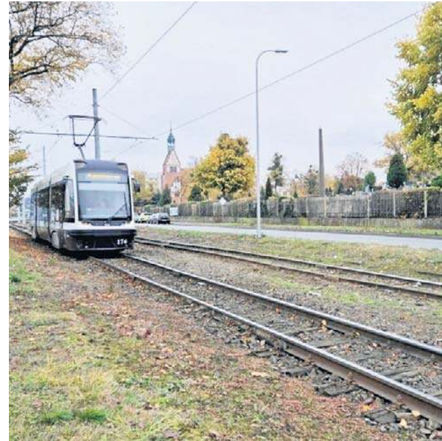
Prace na torowisku rozpoczną się na odcinku od ronda Toruńskiego do Perłowej.
