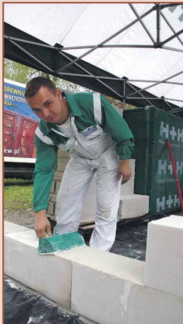
Co w tym roku zaprezentuje nam branża budowlana?
