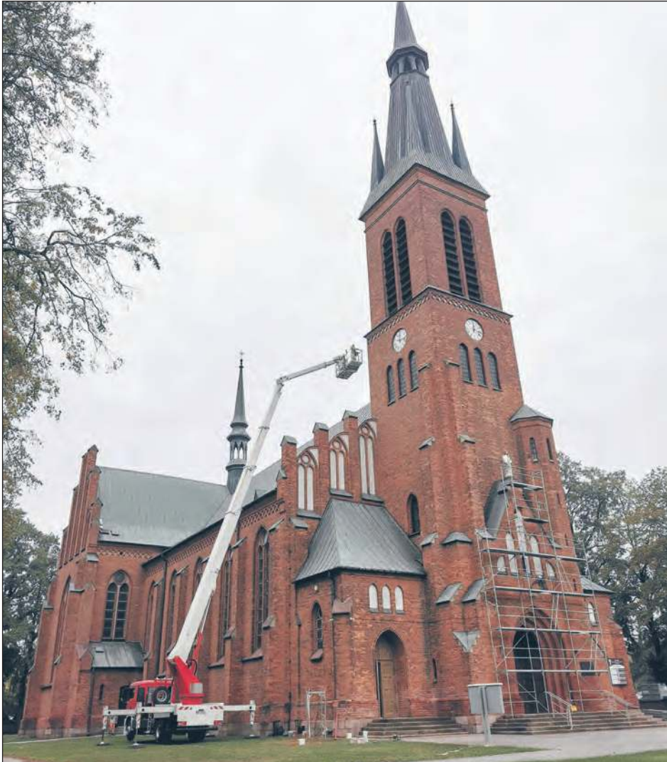
➦ Cegła najpierw musi zostać dokładnie umyta, a następnie zaimpregnowana specjalną krzemionką. Preparat ma za zadanie nie tylko wygładzić, ale też utwardzić ściany, aby cegła nie kruszyła się przez kolejne lata
