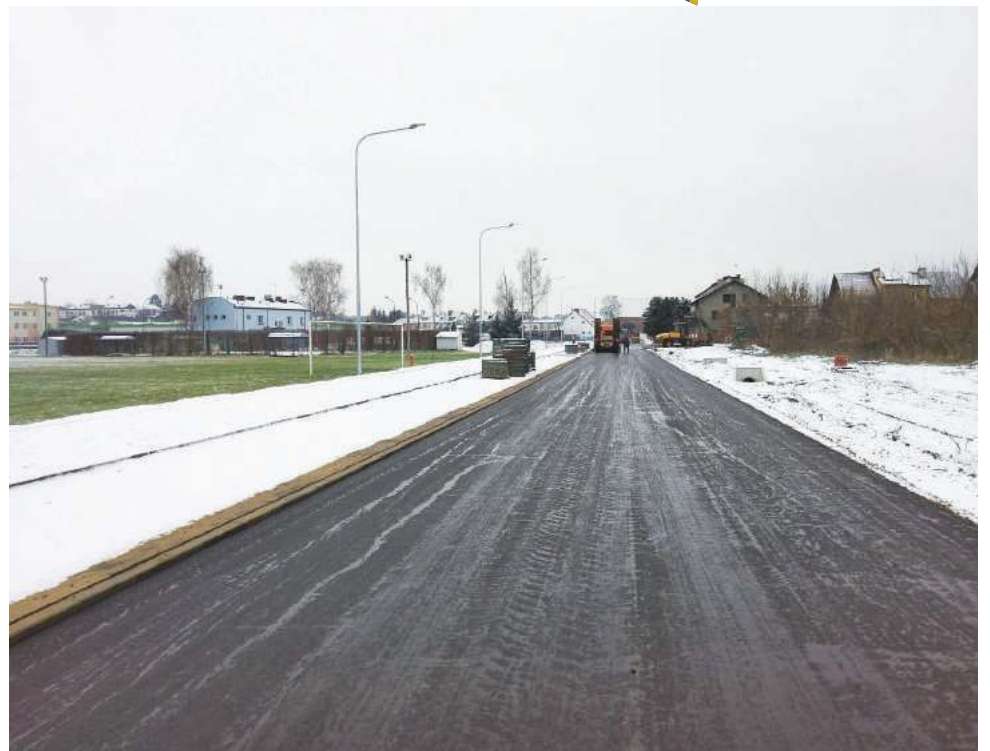
Prace przy tak zwanej małej obwodnicy Pułtusk zblizają się ku końcowi źródło:pultusk.pl
