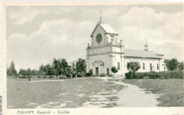
Przebudowa 1936/37 zupełnie zmieniła kształt świątyni - zginęły dzwonnica i „bania”, budynek otynkowany, fronton otrzymał kształt właściwy dla architektury zachodnioeuropejskiej
