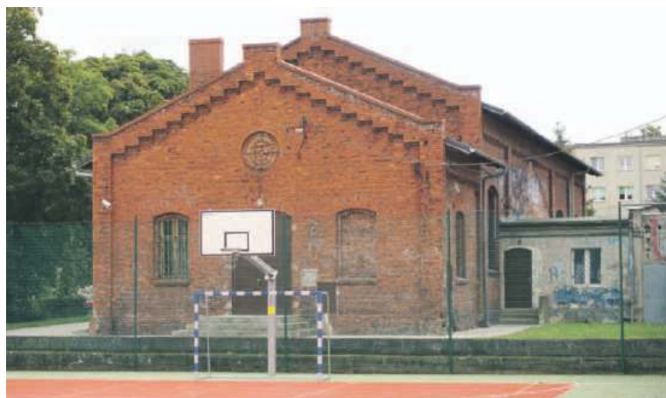
Budynek sali gimnastycznej obecnie.
