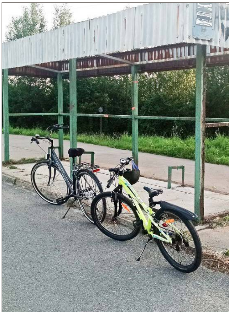
Jedna z usuniętych wiat przystankowych tu jeszcze w trakcie rozbiórki.
