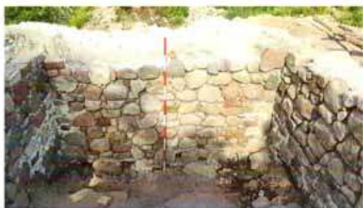
3. Wnętrze wieży zamkowej. Widok ściany wschodniej po rekonstrukcji lica.
