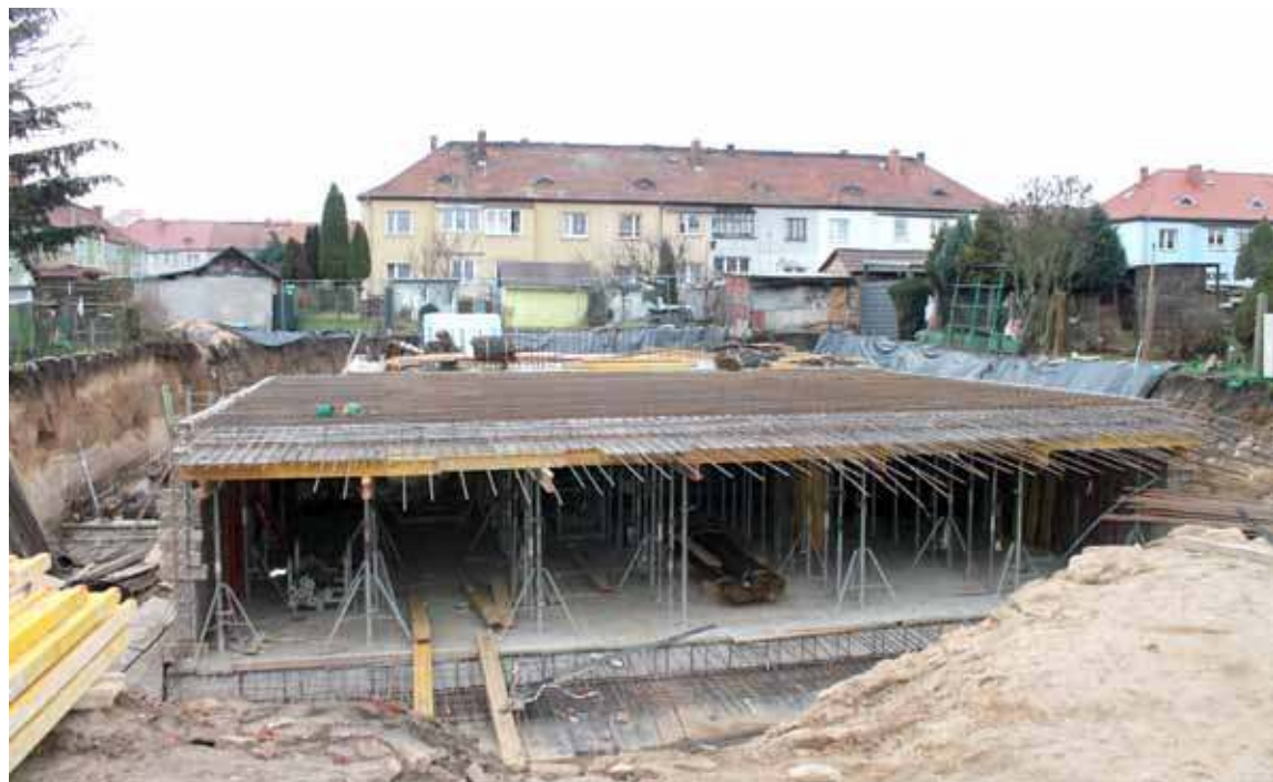
Obecnie w budowie jest podziemny garaż budynku
