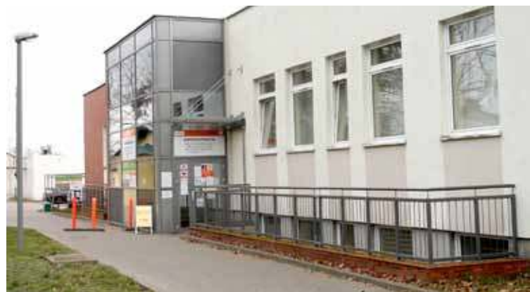
W budynku poradni specjalistycznej od wtorku 5 stycznia rozpoczną się szczepienia przeciw Covid-19
