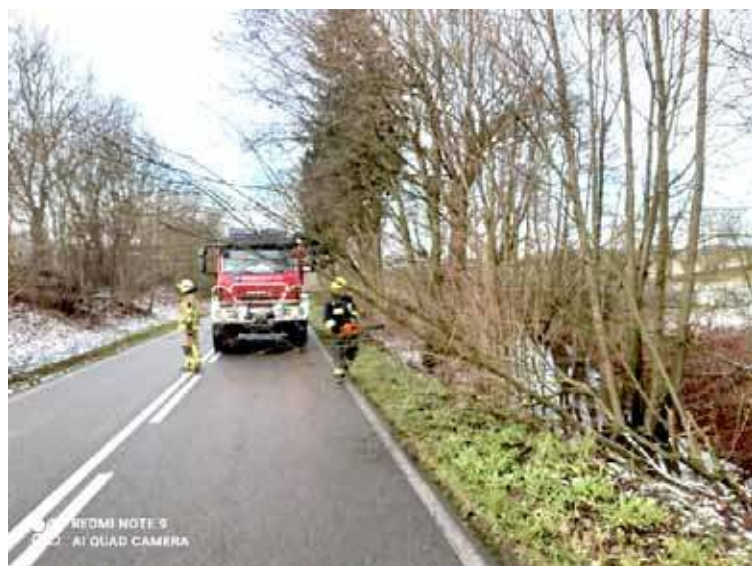
26 grudnia strażacy usuwali złamaną gałąź na drodze między miejscowościami Ińsko i Kamionka. Foto. OSP Ińsko
