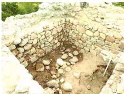
2. Wnętrze wieży zamkowej. Widok ściany zachodniej i północnej po rekonstrukcji lica.
