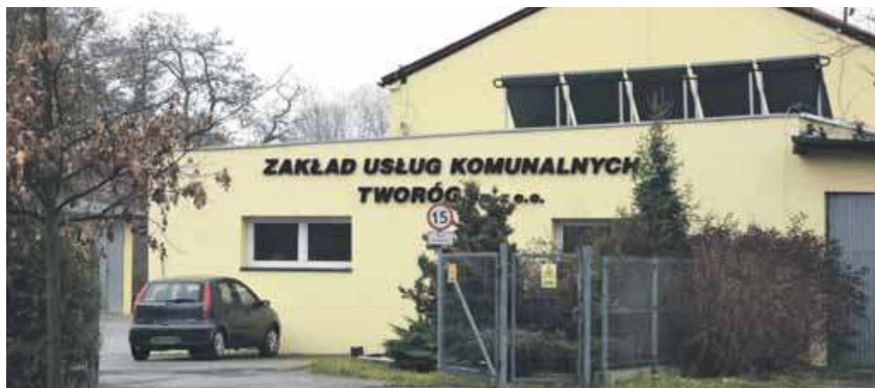
ZUK w Tworogu o dotację na stację uzdatniania wody w Boruszowicach starał się od kilku lat. Udało się za trzecim razem
