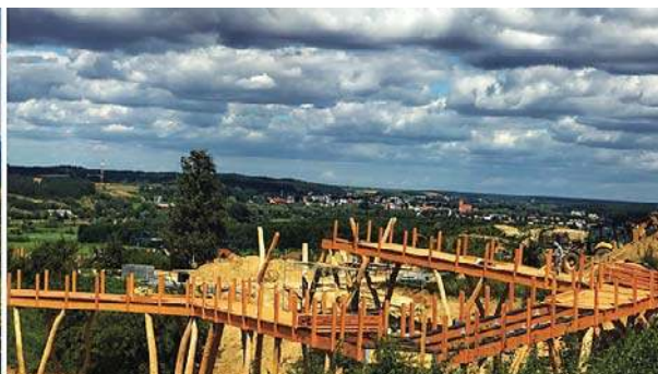
Wieża w Kurzętniku w budowie
