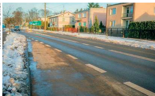
Remont drogi trwał ponad 3 lata
