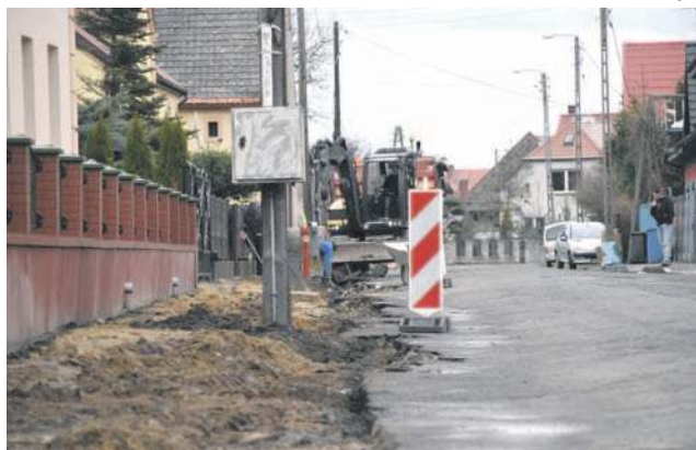
W Domaniowie trwa remont drogi gminnej biegnącej przez miejscowość
