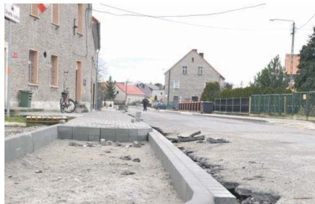
Chodniki będą po obu stronach drogi
