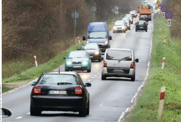
Budowa obwodnicy Olsztyna i Dywit w wersji wschodniej zakłada też przebudowę drogi 51 przez Las Miejski
