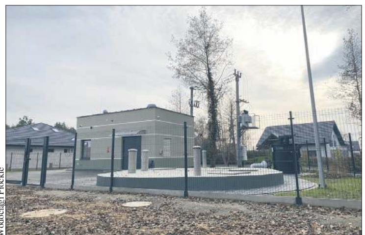
Przepompownia „Andoria” jest jednym z największych tego typu obiektów w kraju
