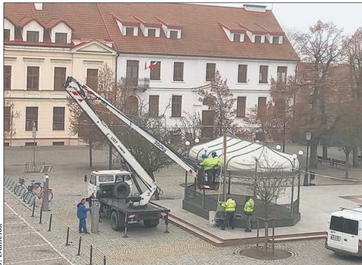
Na Starym Mieście trwa montaż świątecznych iluminacji
