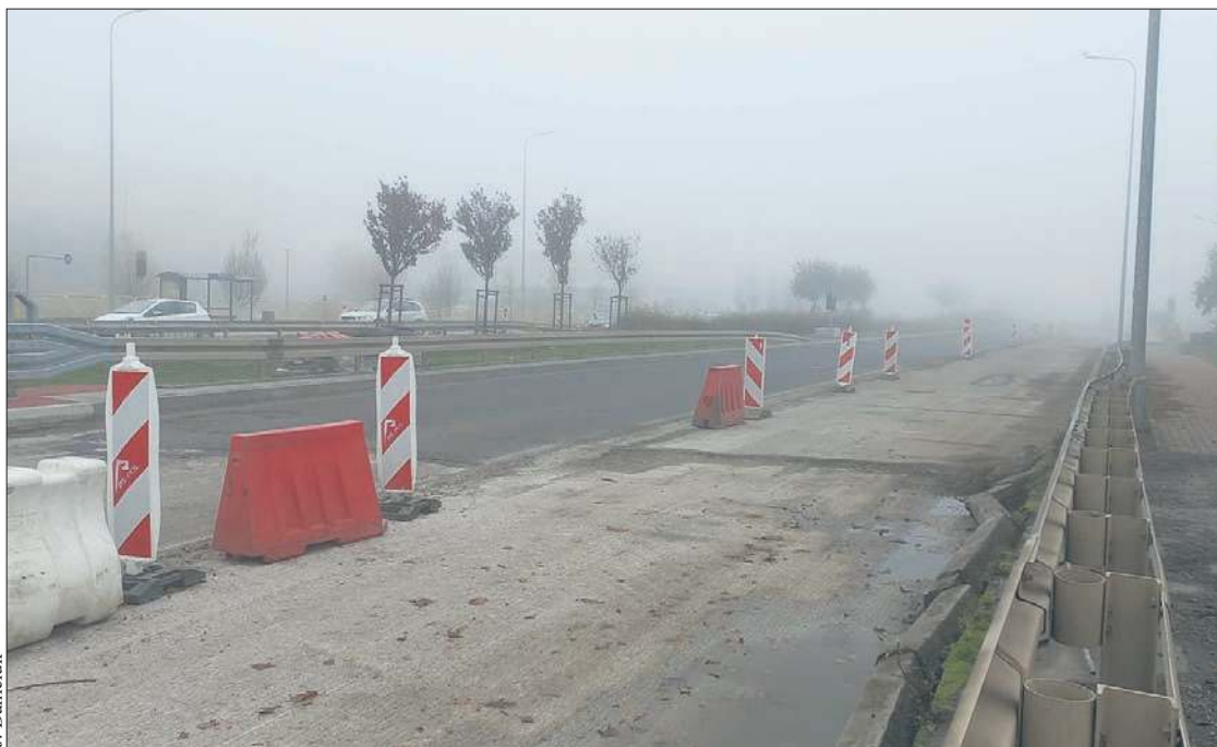
W ubiegłym tygodniu do zakończenia prac brakowało ułożenia nawierzchni asfaltowej na wiaduktach
