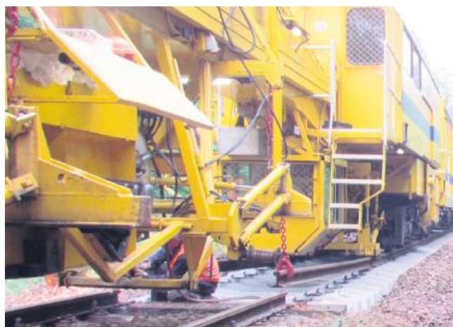
Podkłady wymienia specjalistyczna maszyna PUN. Fot. PKP Polskie Linie Kolejowe
