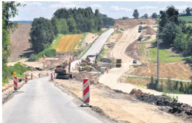
Prace rozpoczęły się pod koniec października ub. roku.
