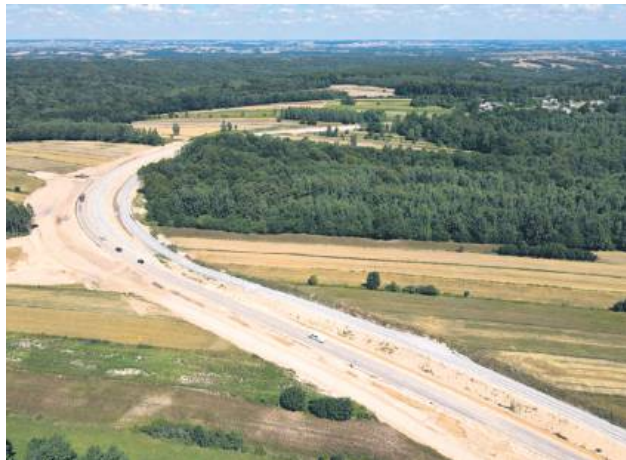
Między Janowem Lubelskim a Zamościem powstanie ponad 60 km nowych lub zmodernizowanych odcinków drogi krajowej nr 74.
