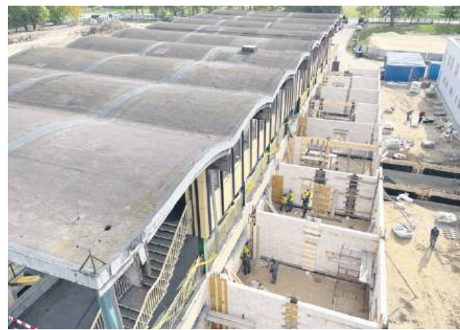
Powstaje nowoczesne zaplecze sanitarno-szatniowe, pomieszczenia magazynowe, a także biura.
