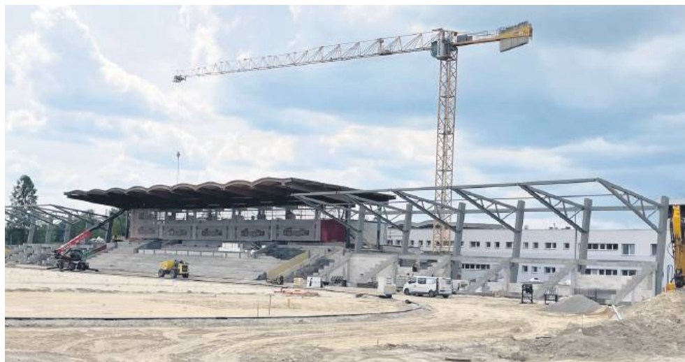
W ramach zadania gruntownie przebudowywana jest trybuna główna, a więc „serce stadionu”.
