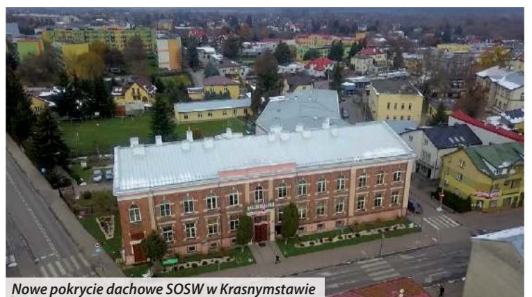
Nowe pokrycie dachowe SOSW w Krasnymstawie
