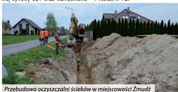
Przebudowa oczyszczalni ścieków w miejscowości Żmudź
