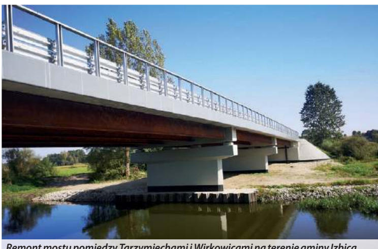
Remont mostu pomiędzy Tarzymiechami i Wirkowicami na terenie gminy Izbica
