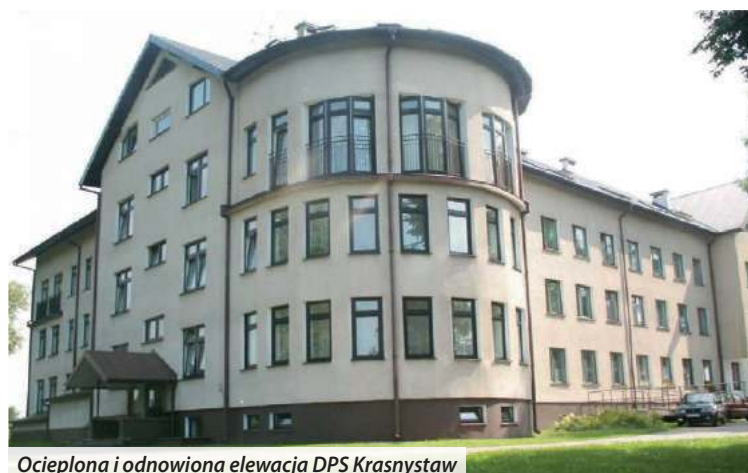
Ocieplona i odnowiona elewacja DPS Krasnostaw
