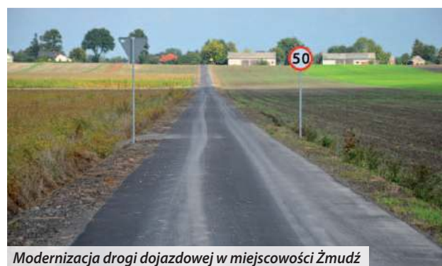
Modernizacja drogi dojazdowej w miejscowości Żmudź
