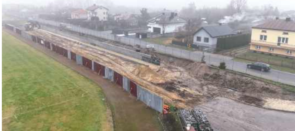
Jedną z trwających inwestycji, która zostanie zakończona w 2025 roku, jest budowa trybun na stadionie miejskim
