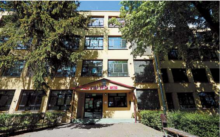
Jedną z trzech szkół, które przejdą termomodernizację i zyskają instalację fotowoltaiczną, będzie Zespół Szkół Transportowych i Komunikacyjnych
