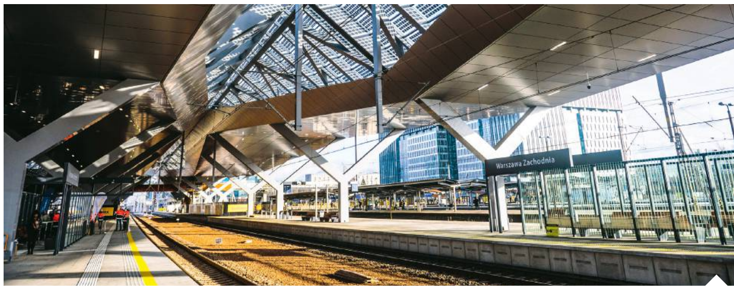
Słowaccy ministrowie odbyli wizytę studyjną na inwestycji przebudowy Dworca Zachodniego w Warszawie, która jest jednym z największych projektów infrastrukturalnych realizowanych w stolicy | fot. Filip Błażejowski/Gazeta Polska
