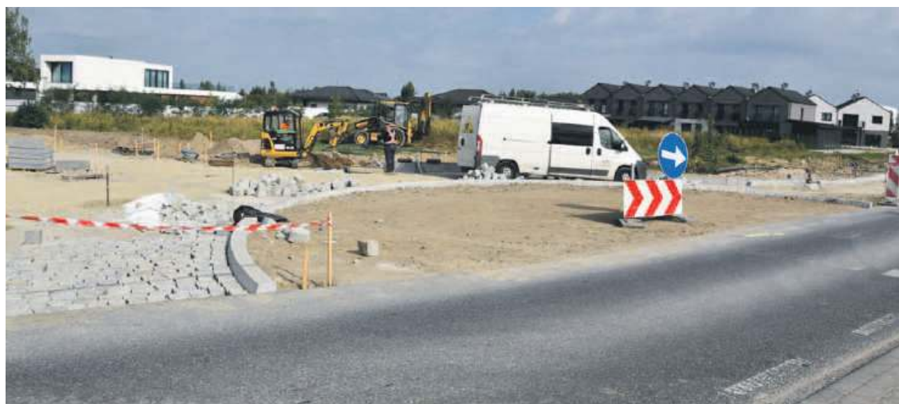
Trwa budowa ronda w Jelczu-Laskowicach
