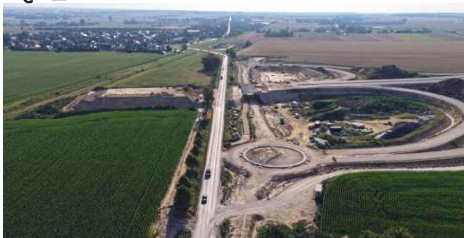
Widok na węzeł Zamość Północ. Fot. GDDKiA
