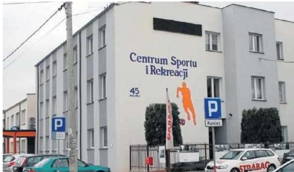
Na terenie Centrum Rekreacji i Sportu w Warce zakończono kolejny etap prac remontowych.
