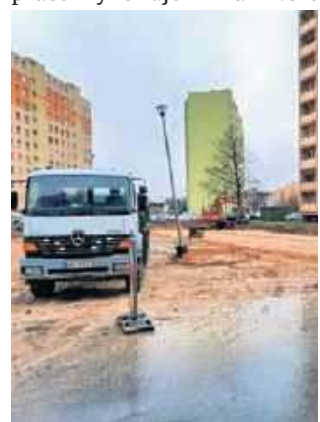
Plac przy Limanowskiego 80 wciąż jest rozkopany.
