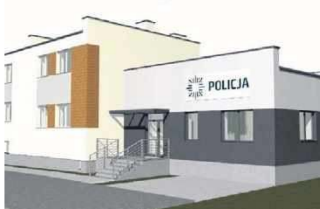
Budynek po inspektoracie weterynaryjnym ma przejść przebudowę. Powstaną mieszkania i komisariat policji.
