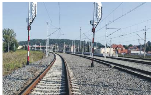
Zmodernizowana linia kolejowa, odcinek w Kłodzku
