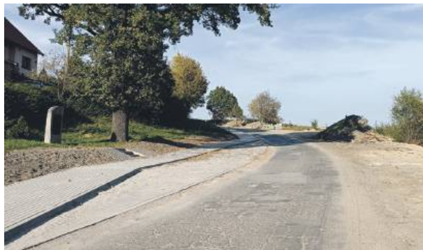
W ramach przebudowy ul. Kaczerki w Kuropatniku wykonano już chodniki wzdłuż drogi gminnej. Po lewej stronie widoczna zatoka autobusowa
