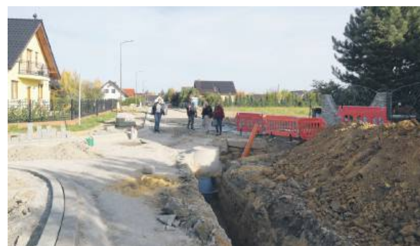
Na Osiedlu Wschodnim w Strzelinie trwa drugi etap remontu ulicy Wincentego Kadłubka. Fot.UMiG Strzelin
