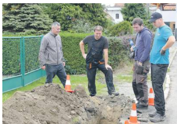
Firma Radio-Net złożyła wniosek do urzędu gminy o udostępnienie słupów oświetleniowych, aby umożliwić podwieszenie kabli światłowodowych. Na początku października prowadzone były prace ziemne związane z instalacją szybkiego internetu
