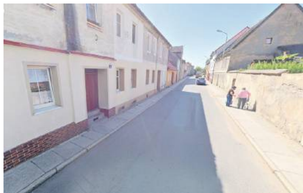
Remont ul. Strzelińskiej w Wiązowie ruszy po nowym roku
