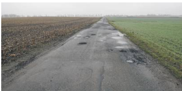
W pierwszym etapie zostanie przebudowany odcinek drogi o długości ponad 1,3 km. Fot. UMiG Strzelin
