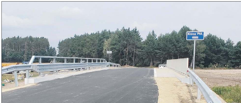
Przebudowie i modernizacji w ramach drogowych inwestycji podlegają też mosty w Misiach
