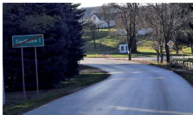
Przebudowa drogi powiatowej Suchodoly-Siedliska-Ksawerówka
