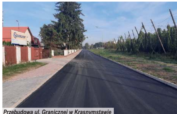
Przebudowa ul. Granicznej w Krasnymstawie
