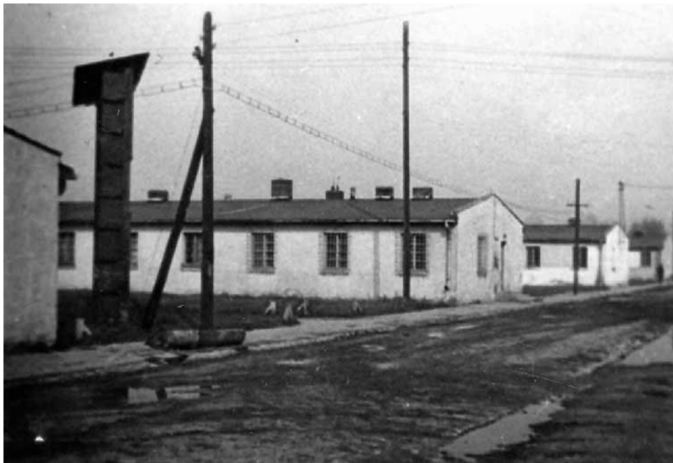
Tak baraki podobozu Ha-Ga Łagisza w Będzinie wyglądały w 1964 roku. Na tym terenie znalazł się m.in. basen przeciwpożarowy, za ogrodzeniem stały strażnice
