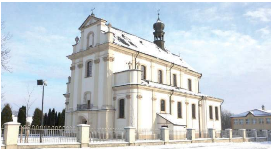
Zakończyły się prace przy elewacjach kościoła pw. Przemienienia Pańskiego w Tarnogrodzie
