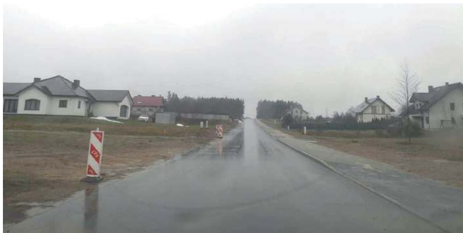
Budowa drogi gminnej w drugiej linii zabudowy w Hedwiżynie jest już na zaawansowanym etapie
