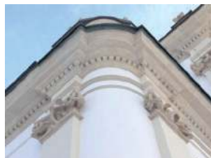
Kamienne detale były pokryte kilkoma warstwami malarskimi, ostatnia z nich była ciemno-szara
