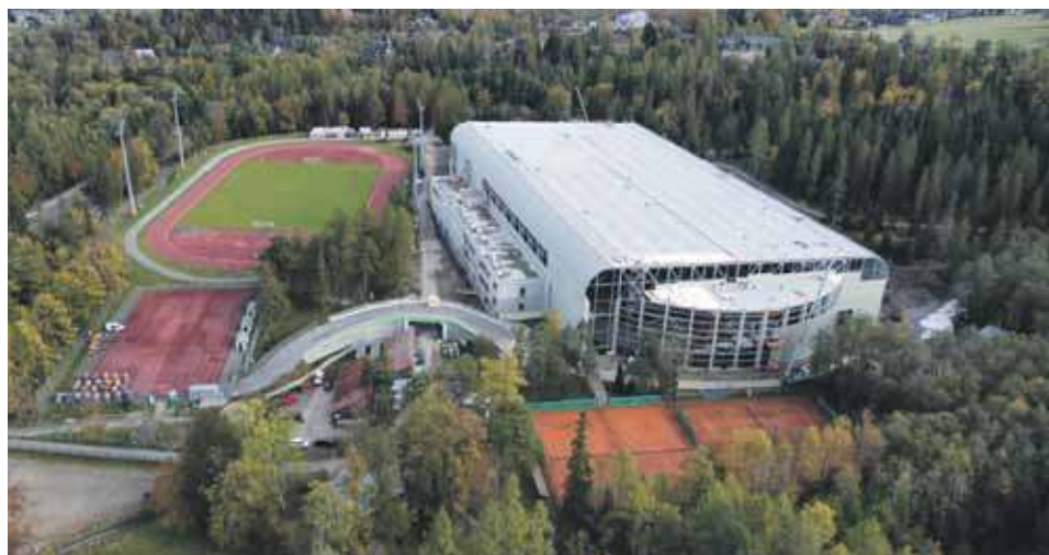
Kryty tor lodowy powstał w kompleksie Centralnego Ośrodka Sportu w Zakopanem.
