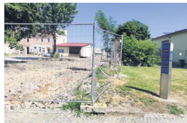
W tym miejscu na działce gminnej przy ul. Pocztowej w Strzelinie powstanie droga wewnętrzna
