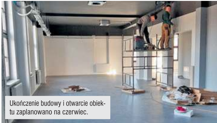
Prace prowadzone są również na zewnątrz budynku.
