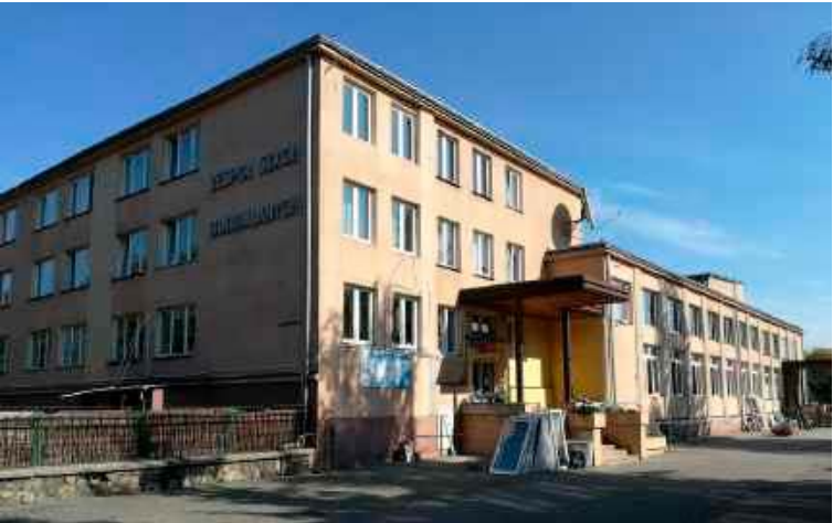
To pierwszy generalny remont „Budowlanki”, która została oddana do użytku w 1964 roku
