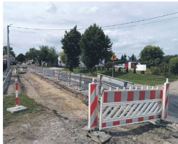
Trwa budowa chodnika przy drodze powiatowej w Bierzynie. Fot. UMiG Strzelin
