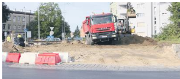
Prace rozpoczęto od zlikwidowania nasypu na wyspie centralnej ronda
