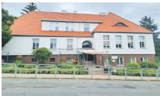
W szkole w Żelowicach wyremontowano dach i ocieplono ściany
