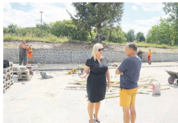
Pod koniec czerwca plac budowy odwiedziła burmistrz Dorota Pawnuk. Fot. UMiG Strzelin
