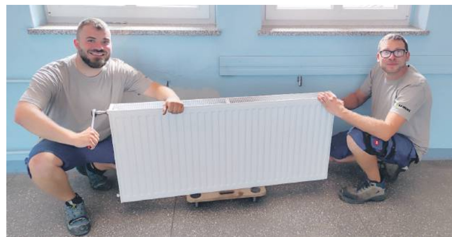
W Ośrodku Zdrowia w Przewornie trawa modernizacja systemu ogrzewania
