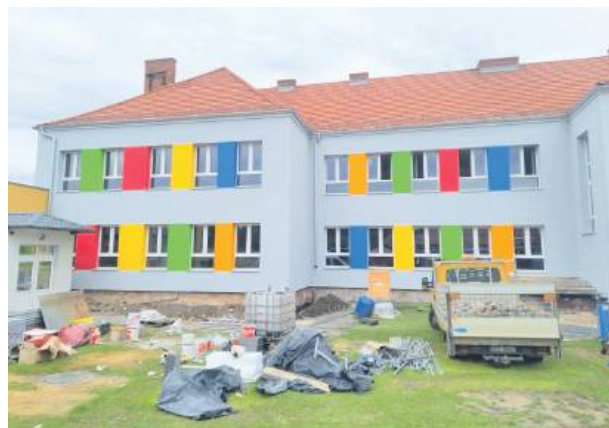
Szkoła w Prusach zyskała nowe ocieplenie, schody i wyremontowano kotłownię
