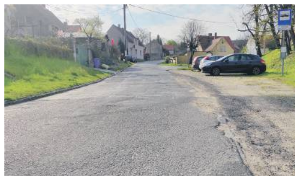
Remont ul. Kaczerki rozpocznie się od skrzyżowania ulicy Strzeleckiej z ulicą Widokową w Kuropatniku
