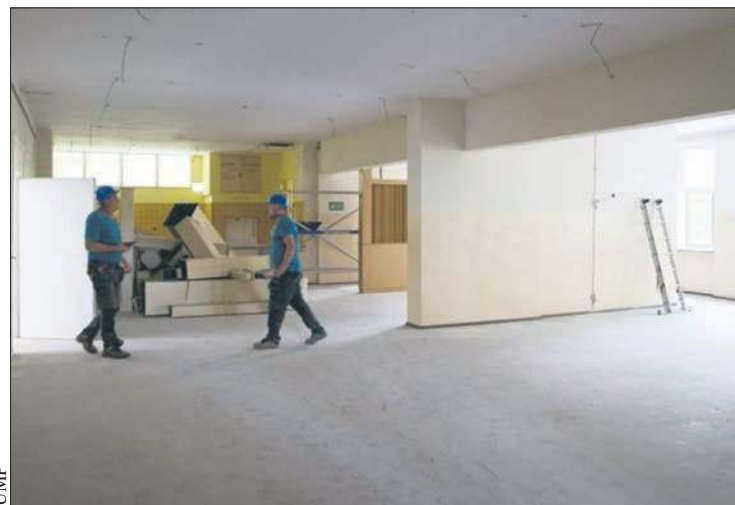
Modernizacja bloku żywieniowego w ZS nr 1 ma być zakończona w grudniu br.
