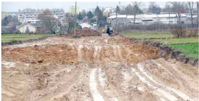
Prace już trwają
