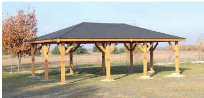
Podobne konstrukcje można spotkać w innych miejscowościach powiatu. Ostatnio taka wiatra stanęła także np. w Janowie w gminie Puławy
