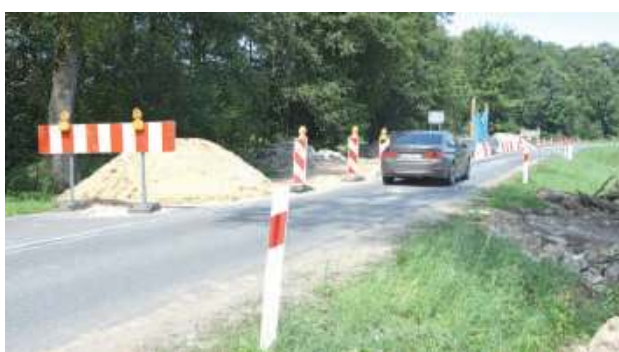
W rejonie prowadzonych prac ruchem kieruje sygnalizacja świetlna
