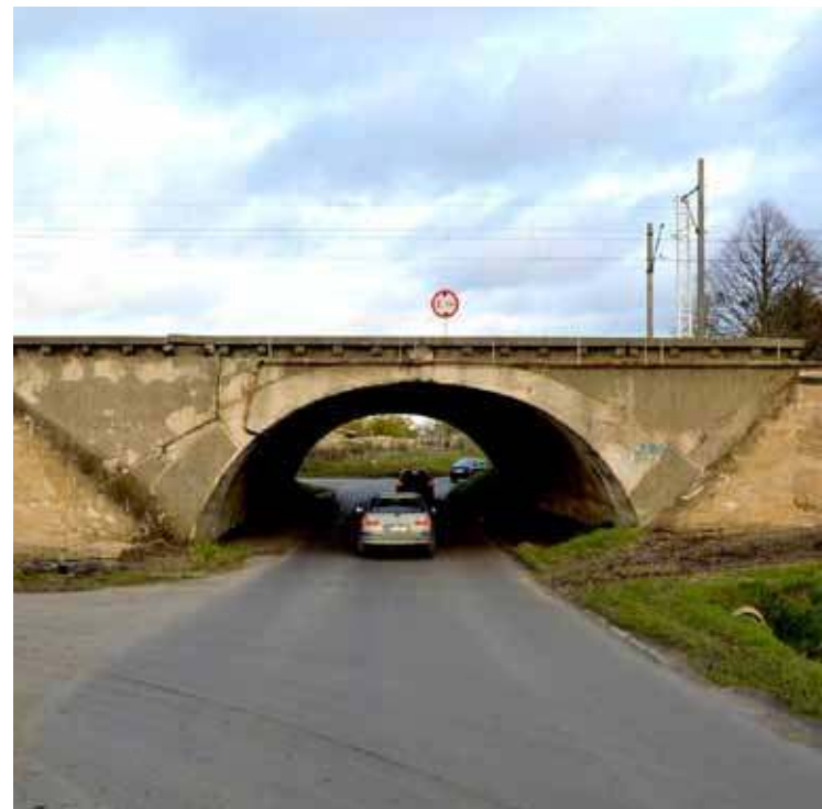
Od poniedziałku 16 listopada z ruchu zostanie wyłączony wiadukt na ulicy Składowej
