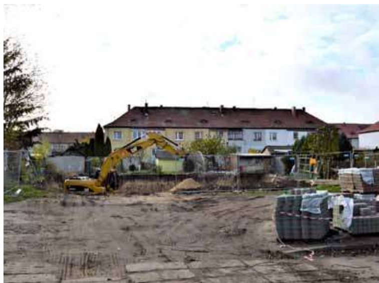
W tym miejscu powstanie trzykondygnacyjny budynek mieszkalny
