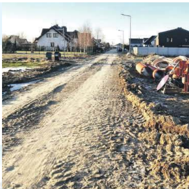
Przebudowa ul. Wiosennej w Krynicznie
