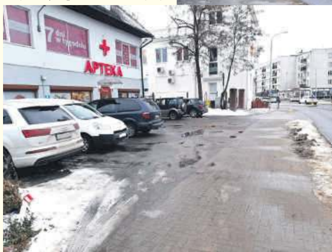
Samochody wyjeżdżając przez około 20 m jadą chodnikiem. Na zdjęciu po lewej stronie widać rozjechany przez nie stulek drogowy
