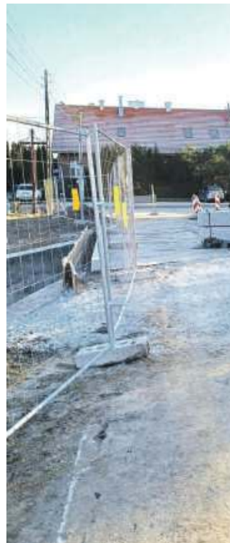
Przebudowa mostu w Strzeszowie
