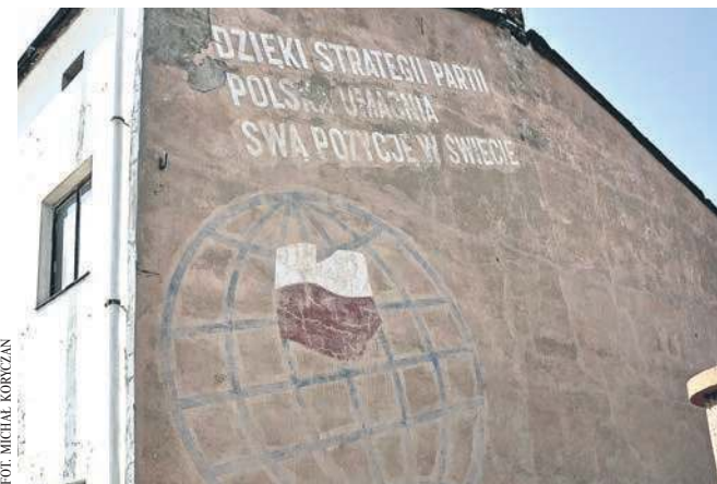
Napis na elewacji budynku przy Kościuszki w Trzebini
