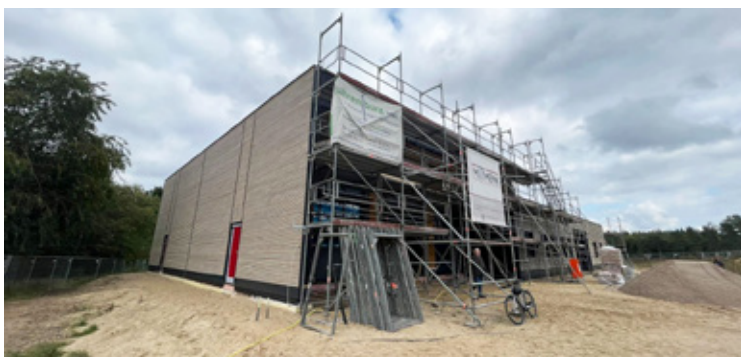
Wykorzystanie technologii grzewczych zeroemisyjnych przy budowie budynku OSP.
