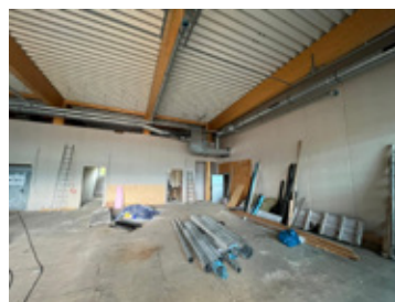
Budowa remizy strażackiej OSP z wykorzystaniem technologii przyjaznej dla środowiska.
