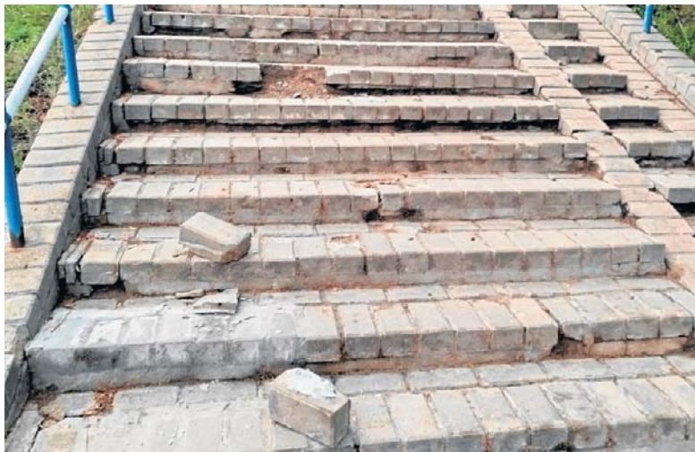
Wyszczerbione stopnie prowadzące na kładkę dla pieszych
